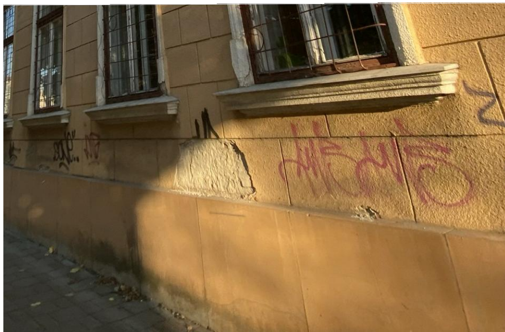
Umiditate de capilaritate Desprinderi tencuieli
